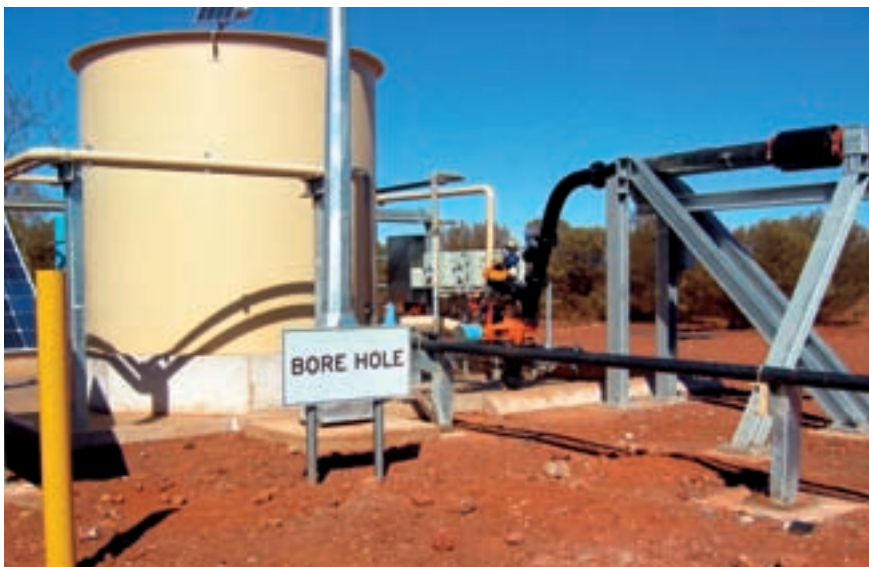
Bohrloch zur Aufnahme der Förderleitung für die Rückverfüllung
