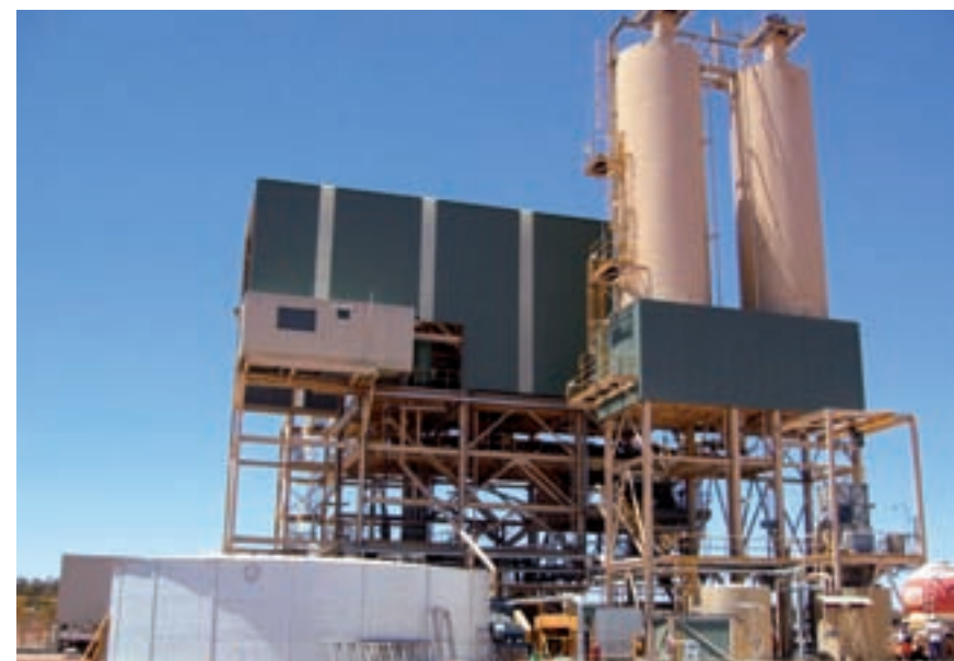
Ansicht einer übertägigen Versatz-Pumpstation mit Silos für Zuschlagstoffe
